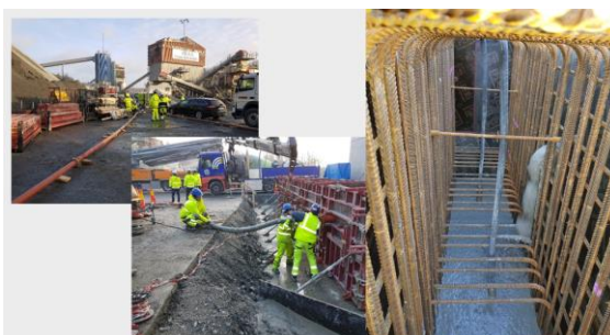
Figur 8: Gjutning av valvkonstruktion (mock-up).
